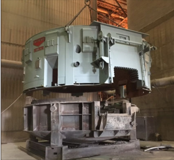
Instalación de la carcasa
