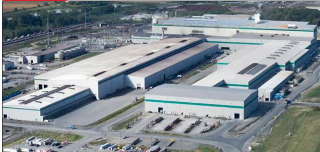
Descripción general de la planta de SDI
